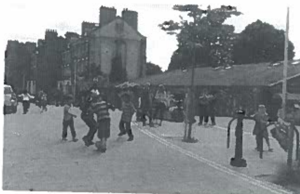
Figura 4: Amenajări ale străzilor de tip „zonă rezidențială” – prioritate pentru pietoni, care pot să utilizeze tot spațiul străzii, limită de viteză 10km/h pentru autovehicule
